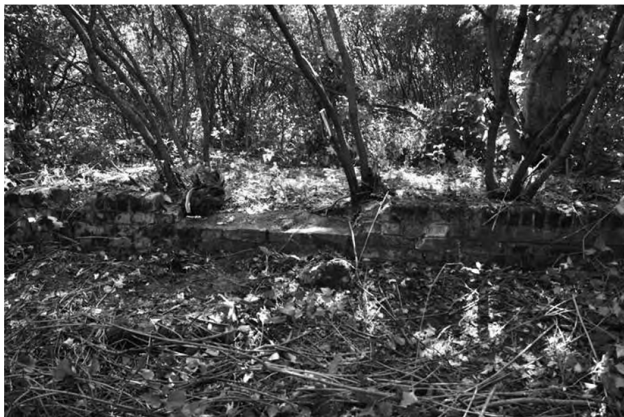
Fot. 9. Widoczny fundament od strony głównej drogi przechodzącej przez Borki. Stan z 16 sierpnia 2013 r. Fot. A. Zglińska
