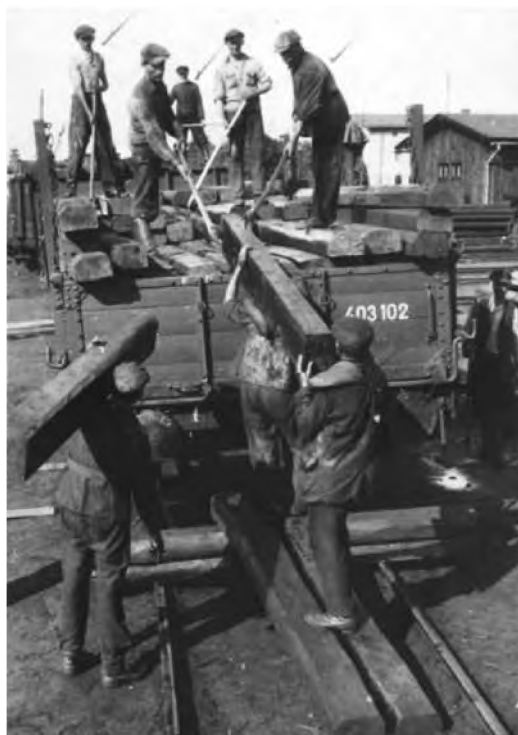
Ręczny załadunek podkładów z wykorzystaniem haków
