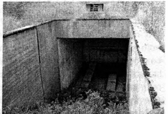
Budynek kaskady popłuczyn
