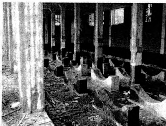
Magazyn kwasów odpadkowych
