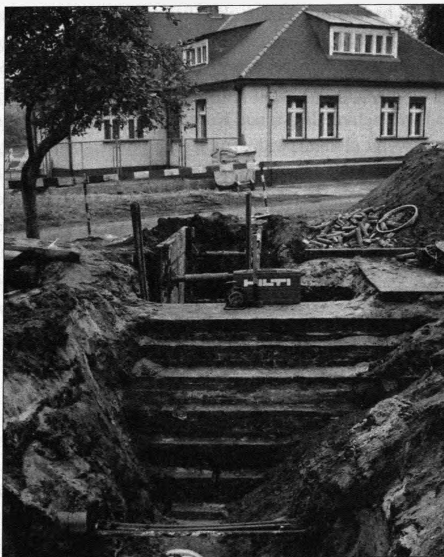
Ryc. 10. Zewnętrzny mur śluzy w trakcie przewiercania. Fot. W. Siwiak.
