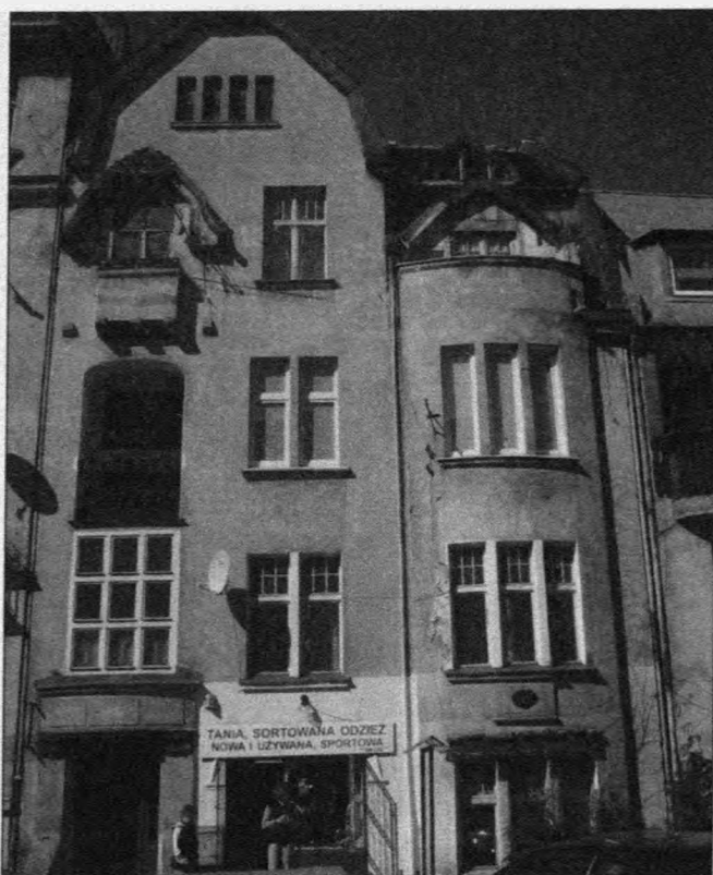
Kamienica przy ul. 20 Stycznia 1920 r. 25, fot. D. Bręczewska-Kulesza.
