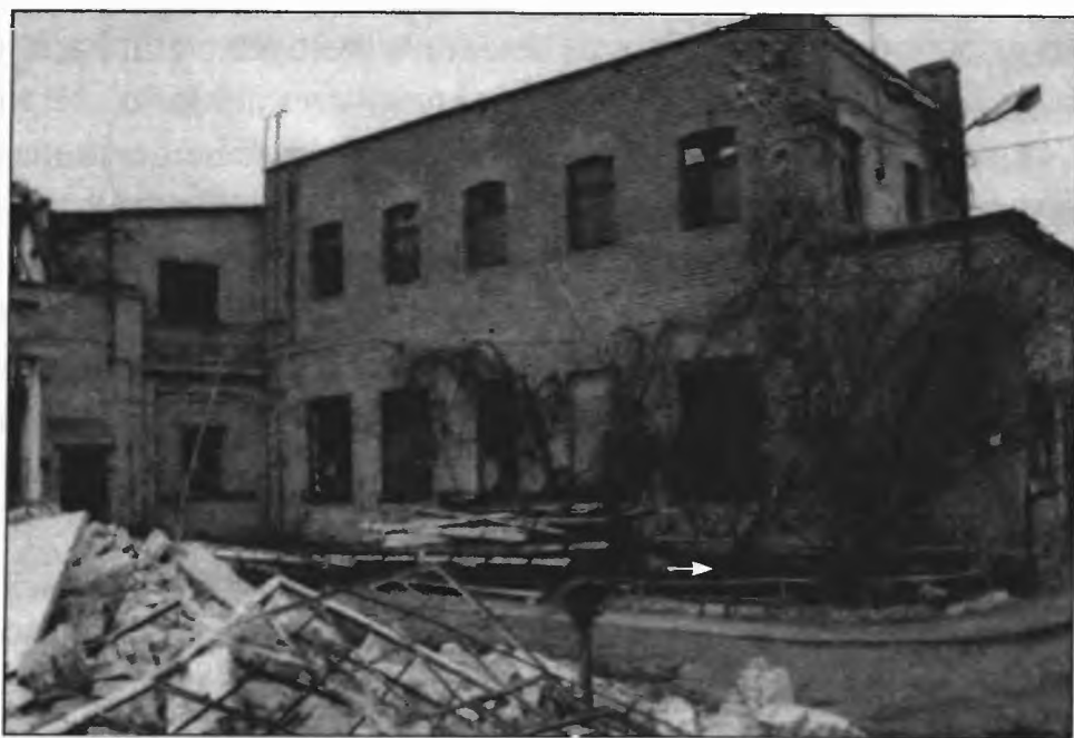
Ryc. 12. Bydgoszcz, zakłady F. Eberhardta. Budynek administracyjny z wejściem do pomieszczenia Brandwache (oznaczone strzałką). Widok: od zachodu. Stan przed rozbiórką. Wykonał: W. Siwiak.
