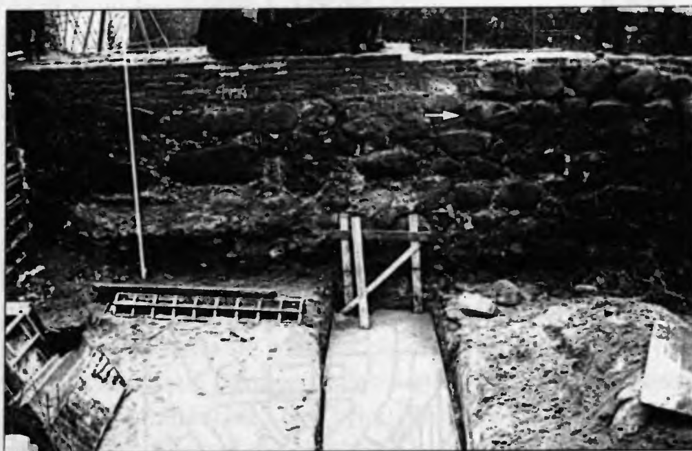
Ryc. 3. Bydgoszcz, stanowisko 553 (ul. Pod Blankami 4). Wykop 1 i 2, wewnętrzne lico muru obronnego. Strzałką zaznaczono miejsce przewiązania różnoczasowych odcinków muru
