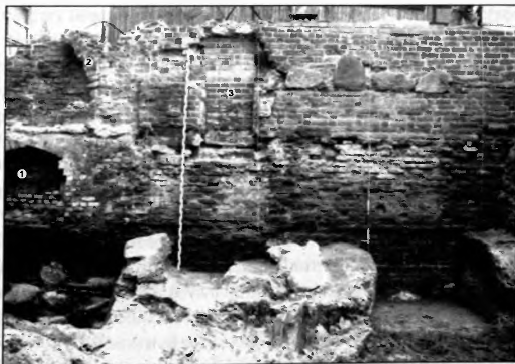
Ryc. 7. Bydgoszcz, stanowisko 437 (ul. Pod Blankami 8). Wykop 1, wewnętrzne lico muru obronnego. Widoczna jest znaczna destrukcja pierwotnego muru, w którym wykonano wnękę (1), łuk ceglany (2), oraz przebito, a następnie zamurowano furtek (3)
