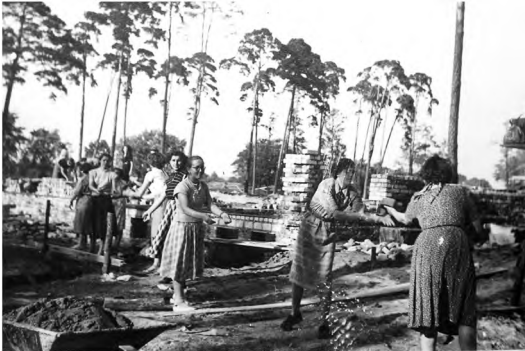
Mieszkańcy Bydgoszczy pomagali przy budowie kąpieliska.
