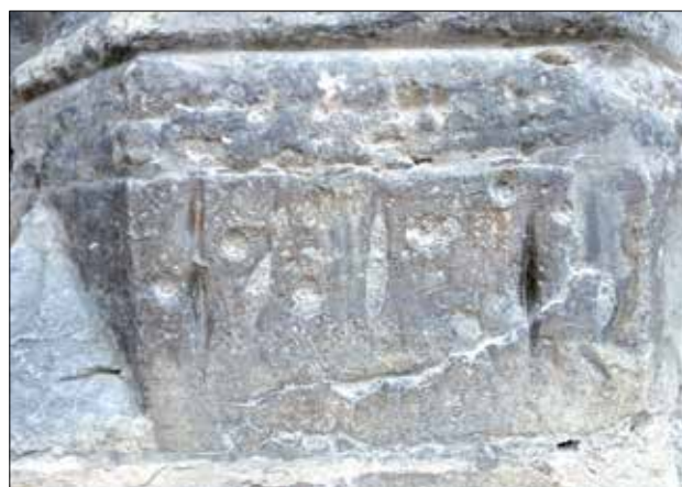
Fot. 16. Ślady dolkowe na portalu południowo-wschodnim w Braşowie.
