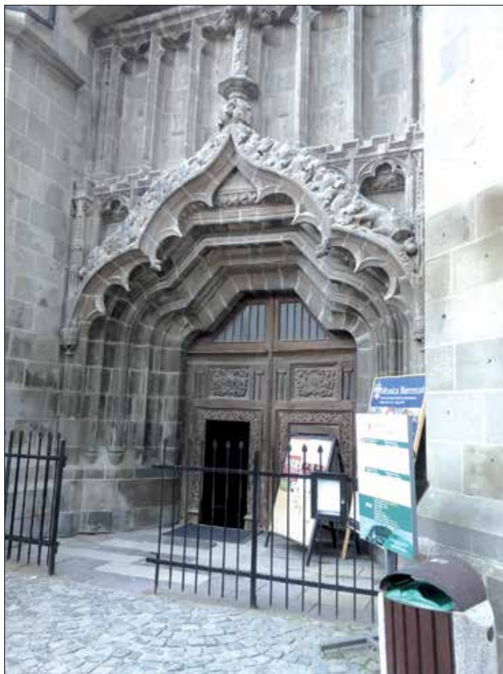
Fot. 12. Portal główny Czarnego Kościoła w Braşowie.
