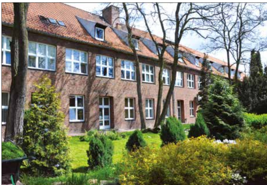
Ryc. 8. Fragment kompleksu szkół dla mniejszości niemieckiej (ob. budynki Uniwersytetu Kazimierza Wielkiego w Bydgoszczy), ul. Chodkiewicza 30
