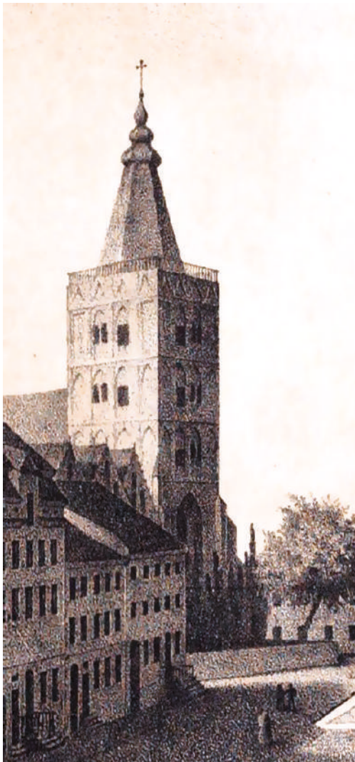
Il. 5. Wieża kościoła farnego na litografii A. Schäfera z 1835 r., przedstawiającej chełmiński Rynek. Balustrada opasująca hełm nie posiada przęseł, a blendy najwyższej kondygnacji wieży zamknięte są trójkątnie (Muzeum Ziemi Chełmińskiej)
