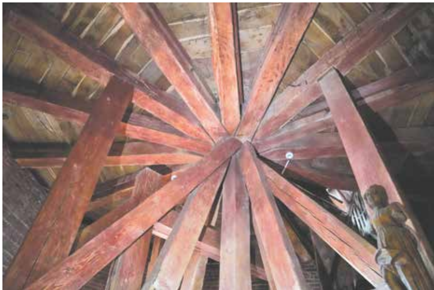
Il. 11. Promieniście układające się więzary więźby hełmu widziane z poziomu czwartej kondygnacji wieży. Po lewej widoczny fragment bębna, na którym spoczywa hełm (fot. A. Soborska-Zielińska)
