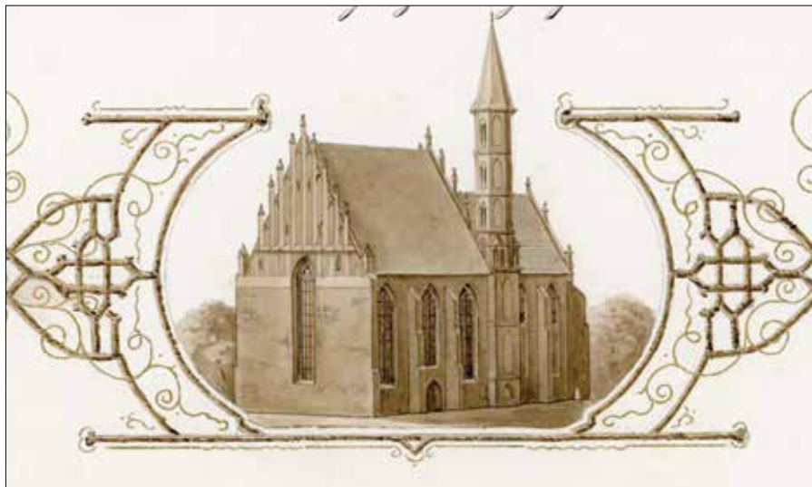
Il. 7. Widok kościoła pofranciszkańskiego, który od 1868 r. służył celom szkolnym.
