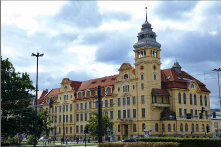
Il. 4. Dawna Królewsko-Pruska Szkoła Rzemiosła i Przemysłu Artystycznego, ob. Zespół Szkół Mechanicznych nr 1 w Bydgoszczy; fot. A. Wysocka.
